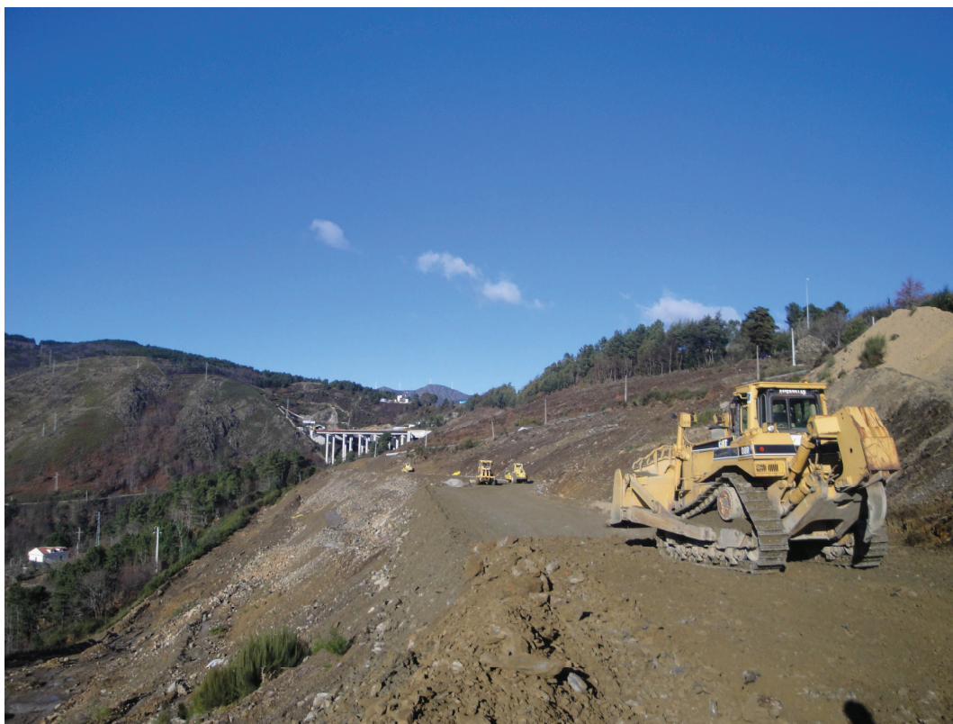
Registo Fotográfico 6 – Trabalhos de Aterro junto ao Pk 20+475
