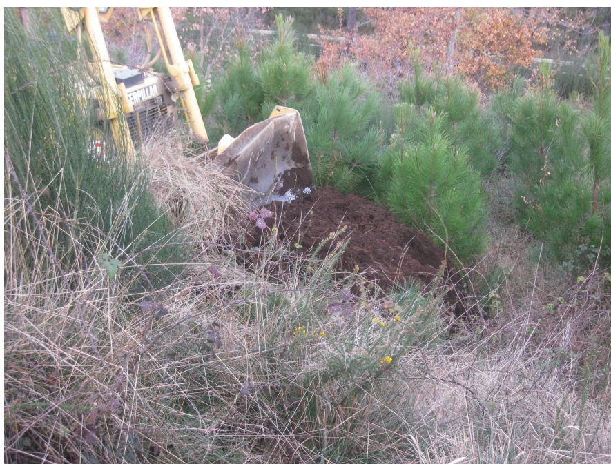
Registo Fotográfico 3 – Trabalhos de Desmatção e Decapagem (Pk 21+075)
