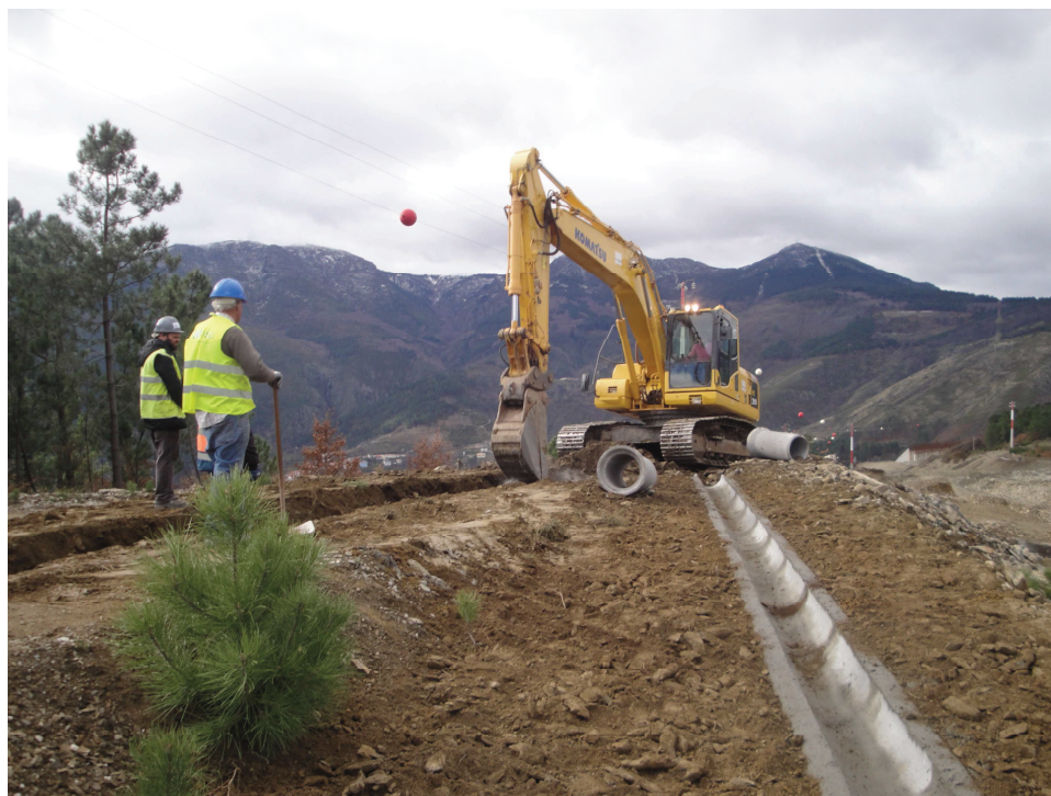
Registo Fotográfico 7 – Trabalhos de Drenagens (valeta de crista) junto ao Pk 21+025
