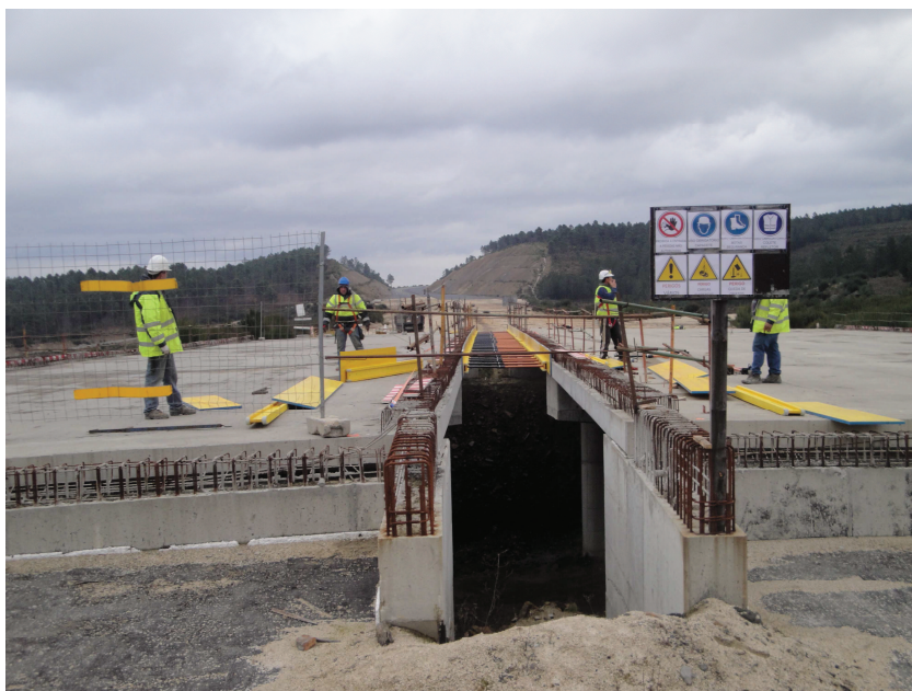
Registo Fotográfico 8 – Trabalhos em Obras de Arte (PI9A)
