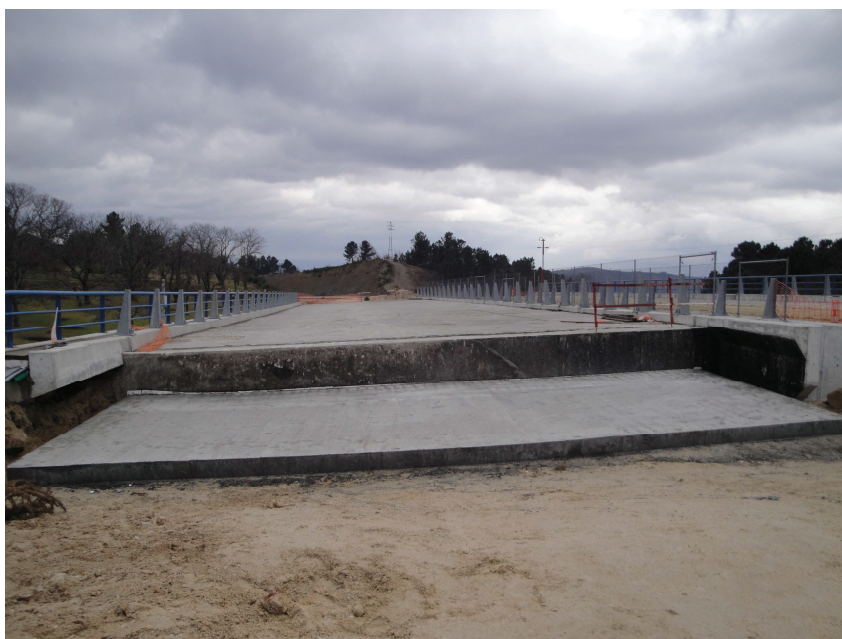
Registo Fotográfico 9 – Laje de transição (Viaduto V11)
