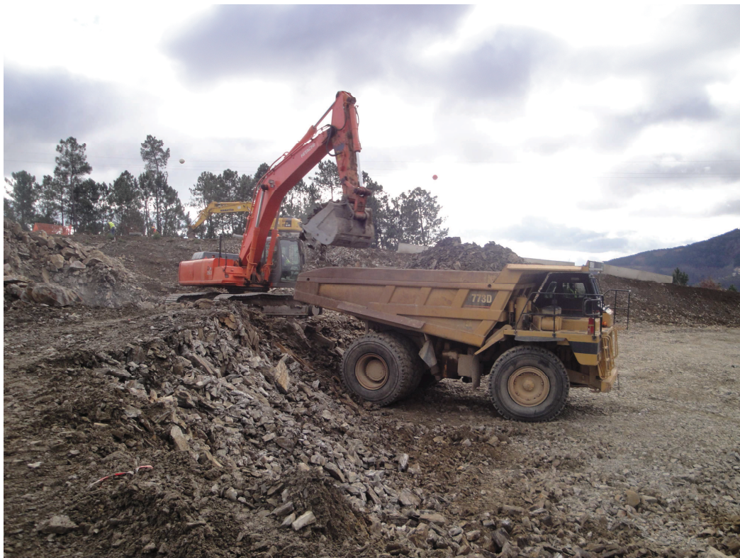
Registo Fotográfico 4 – Trabalhos de Escavação (Pk 20+900)
