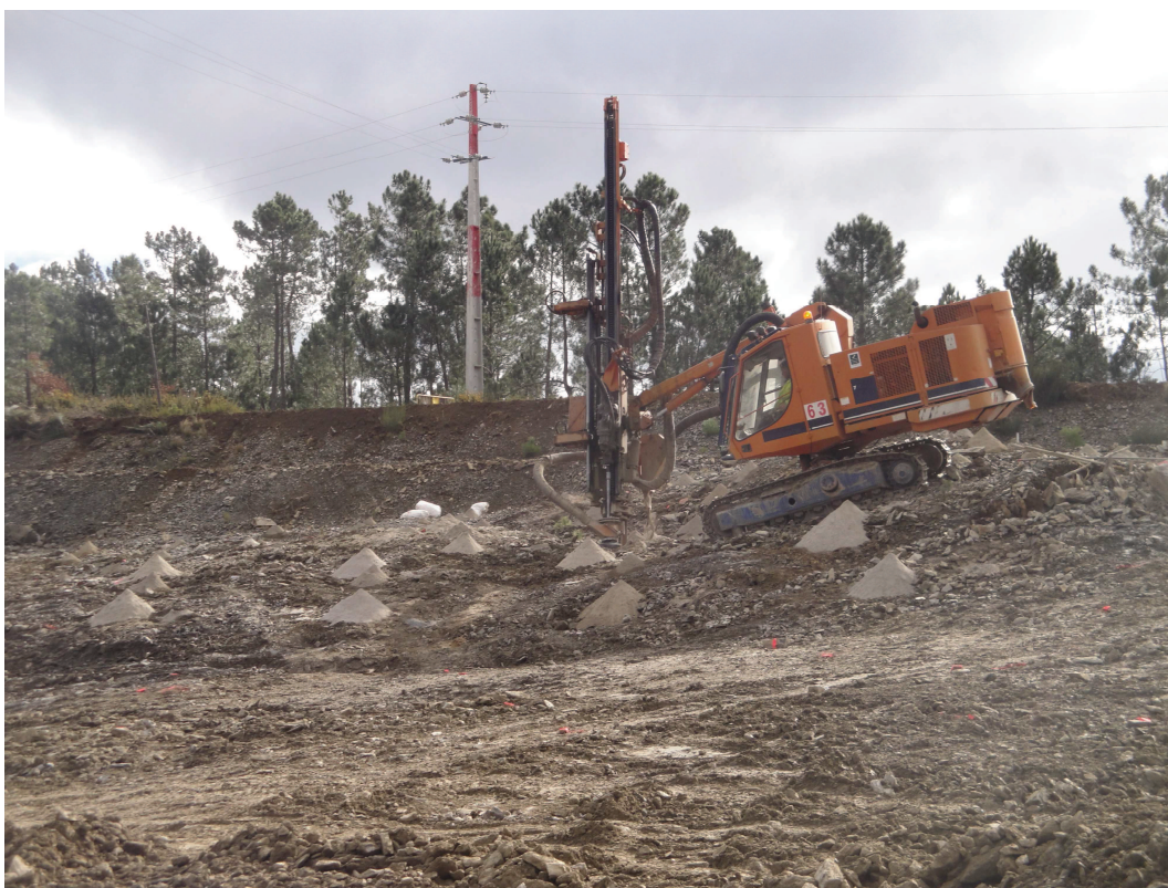
Registo Fotográfico 5 – Trabalhos de Escavação com recurso a explosivos junto ao Pk 21+100
