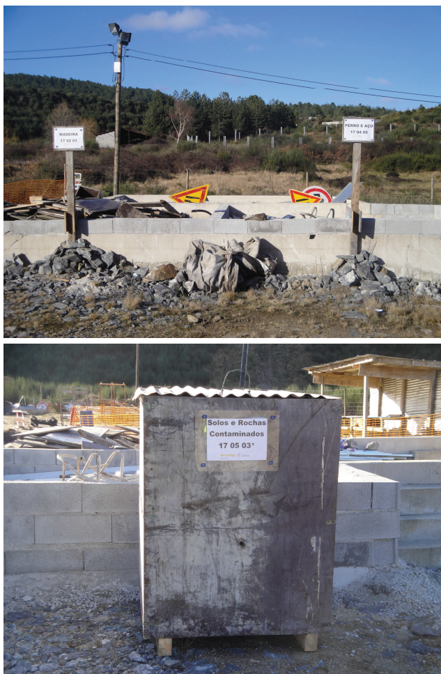
Registo Fotográfico 1 e 2 – Parque de Resíduos – Estaleiro Central (Torgueda)
